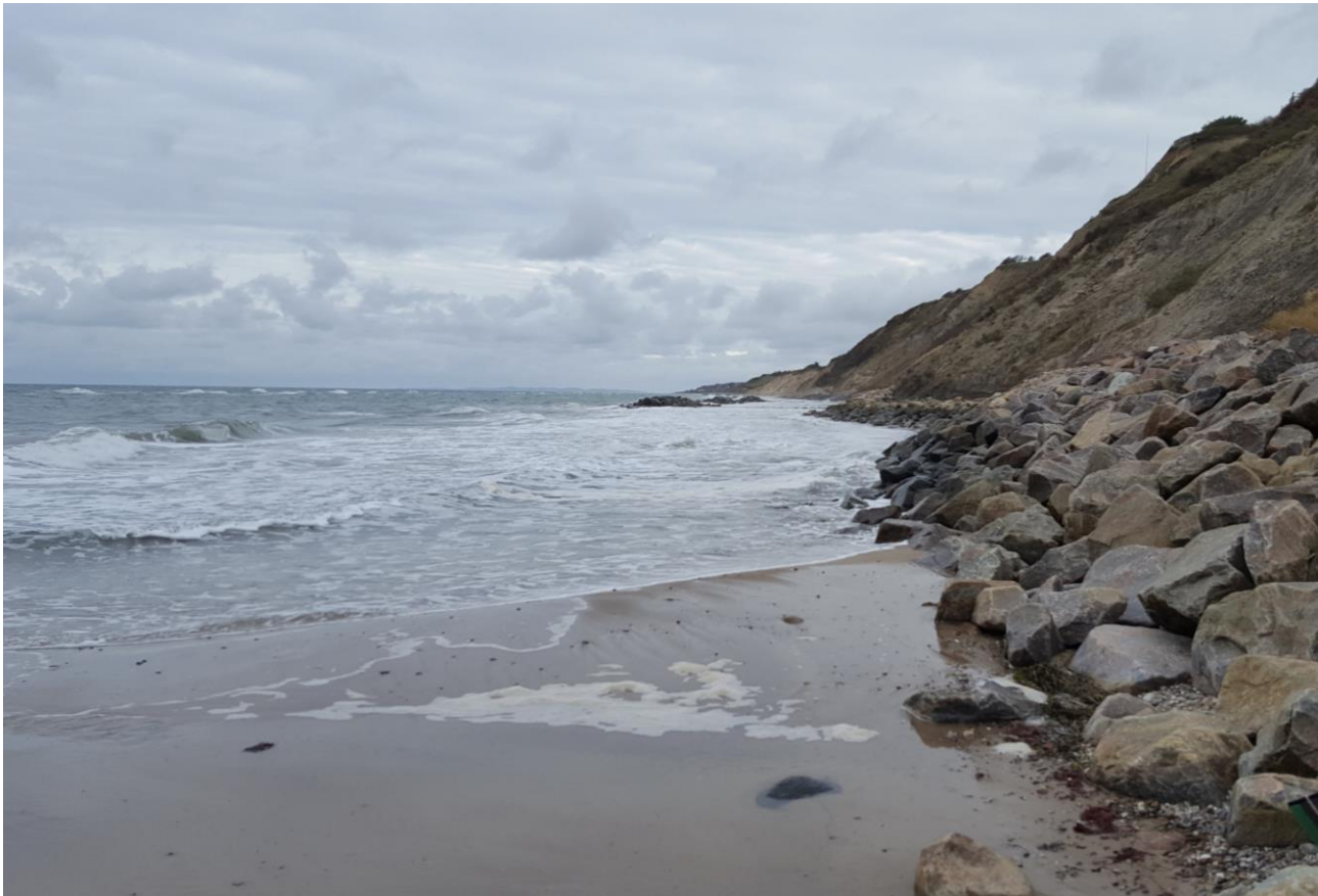
Figur 3.1 Stejl og høj skrånning ved Salgårdshøj med lav skråningsbeskyttelse, der beskytter mod erosion og dermed hindrer tilførsel af materiale til stranden, som er forsvundet foran skråningsbeskyttelsen. Fotoet er taget d. 31-10-2017 af NIRAS.
