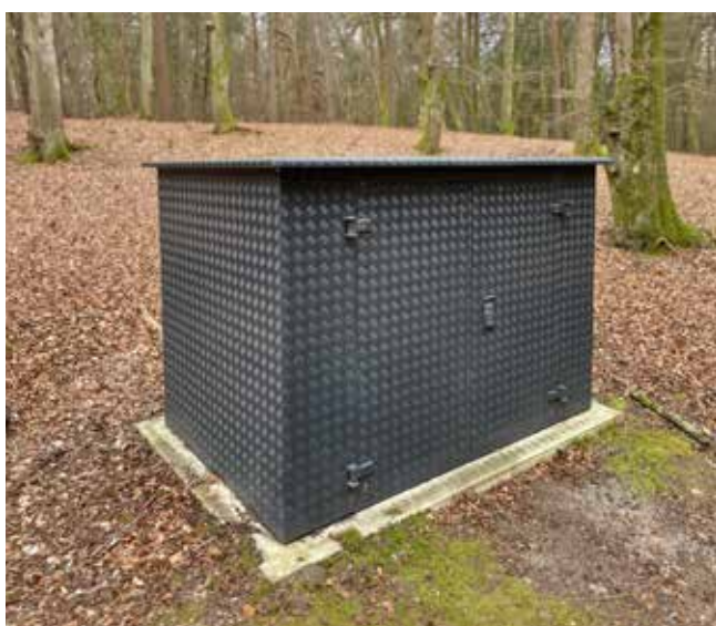
Til sidst bygges et lille hus rundt om boring, pumper etc., så de nye boringer ligner de eksisterende.
